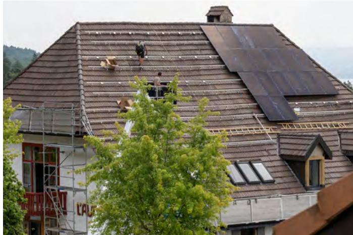
des échafaudages sur l'auberge annonçaient la pose sur le pan sud-ouest d'un champ de panneaux photovoltaïques du même fabricant que les précédents, 125 m<sup>2</sup> pour une production attendue de 30 MWh par an, branchés au réseau avec l'arrivée de l'été. Leur orientation devrait permettre de profiter au mieux du soleil de l'après-midi ce qui devrait être particulièrement intéressant quand la course du soleil est plus basse durant l'hiver.
