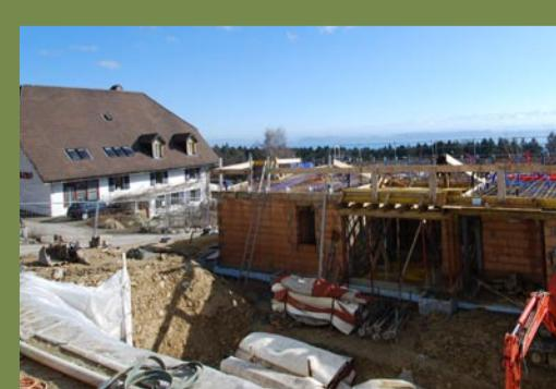
Die ersten beiden Häuser sind mit Fenstern und Dachziegeln versehen und die Arbeiten werden nun im Innern fortgesetzt. Unterdessen wurden die beiden östlich gelegenen Gebäude begonnen und erhalten pro Woche ein Stockwerk aufgesetzt. Mitte März wird der Kran von der Baustelle verschwunden sein und Ende Juni soll das erste Haus bezugsfertig sein.
